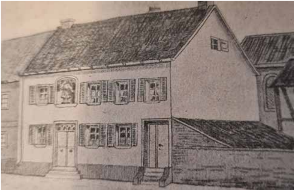
Gesellenhaus auf dem Kirchwall mit Josefsfigur über der Tür links. Das Rundfenster im Hintergrund rechts gehört zur Synagoge in der Annaturmstraße, die ebenfalls ein Raub der Flammen wurde (nach einer Zeichnung von Jean Spessart).
